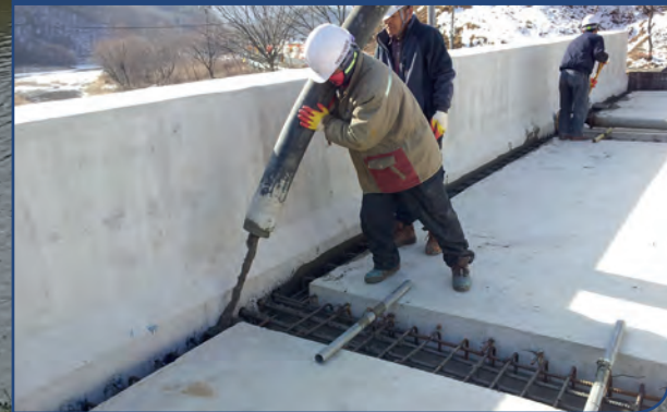
연결부 철근 배근 및 콘크리트 타설
