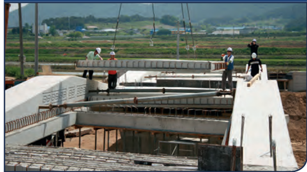
프리캐스트 바닥판 설치
