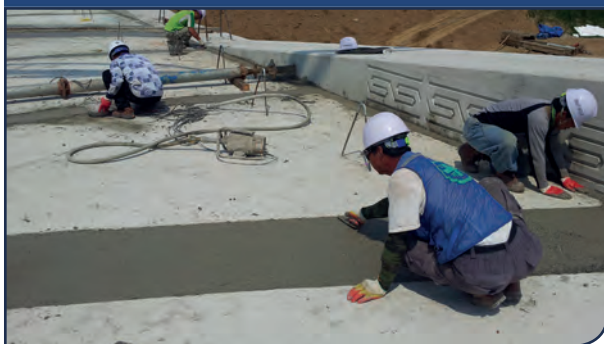
연결부 콘크리트 타설
